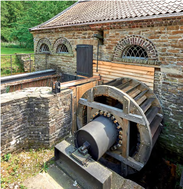
Hammergebäude mit neuem Wasserrad, neuer Wetterschutz- Verbreiterung und neuer Schützenanlage, 2018 © Rainer Rothen- berg/Ruhr Museum
