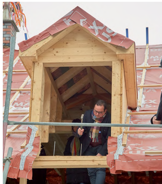
Einschlagen des symbolischen Nagels durch den Oberbürgermeister Thomas Kufen beim Richtfest 2018 © Klaus Kaiser / Konsortium Deilbachtal
