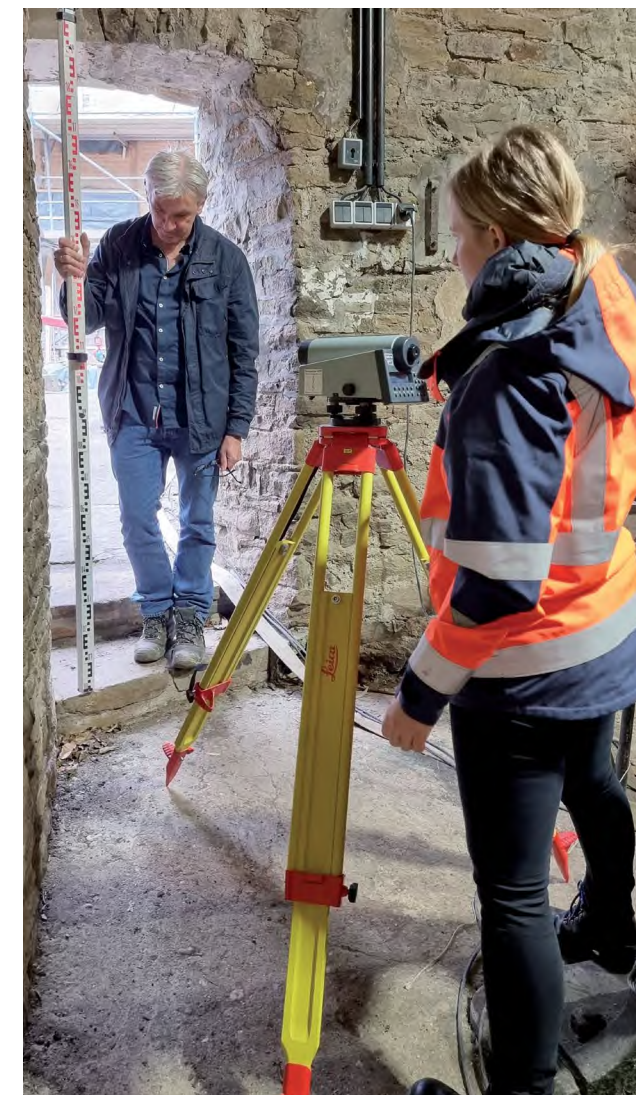
Vermessungstechnische Kontrolle und Einbau der Hammersäulen © Klaus Kaiser / Konsortium Deilbachtal
