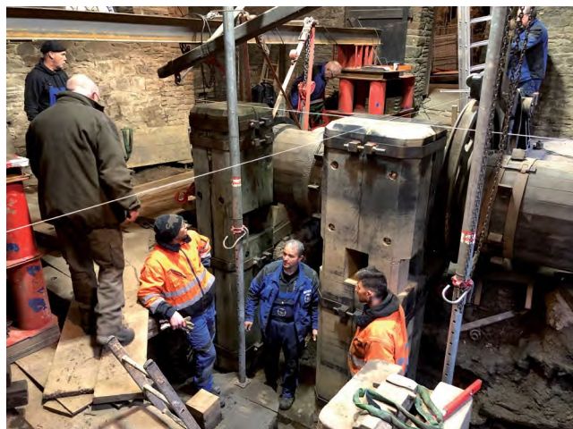
Exakte Platzierung der neuen Hammersäulen in der Baugrube durch die Fa. Nockemann, 2022 © Achim Mikuscheit/Ruhr Museum
