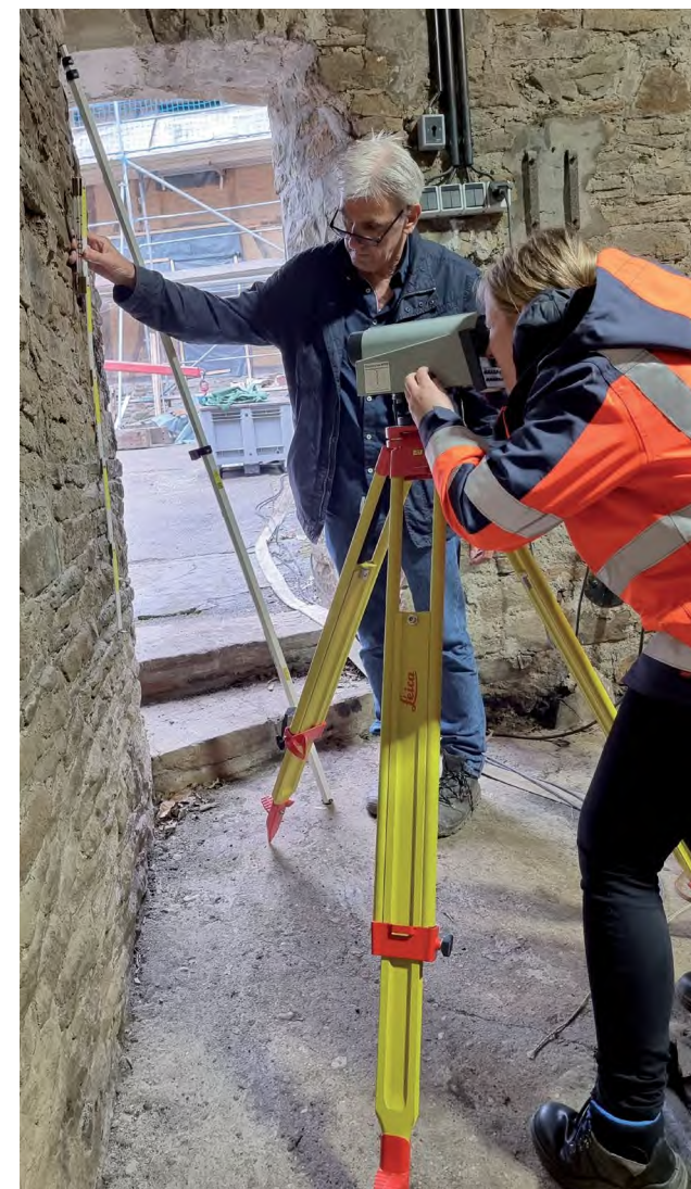
Vermessungstechnische Kontrolle und Einbau der Hammersäulen © Klaus Kaiser / Konsortium Deilbachtal
