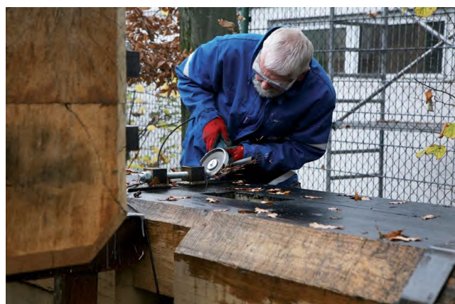
Karl Otto Fuckert mit Flexarbeiten an den Spannbandagen einer Hammersäule, 2020 © Rainer Rothenberg/Ruhr Museum
