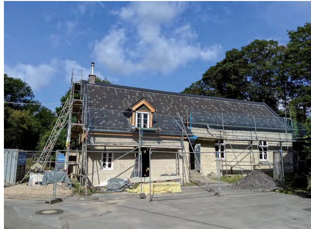
Arbeiterhäuser um 2019 © Klaus Kaiser / Konsortium Deilbachtal
