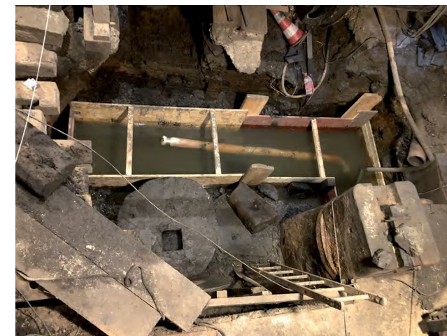
Schalung zum Gießen eines Betonfundaments für die neuen Hammersäulen, 2022 © Achim Mikuscheit/Ruhr Museum
