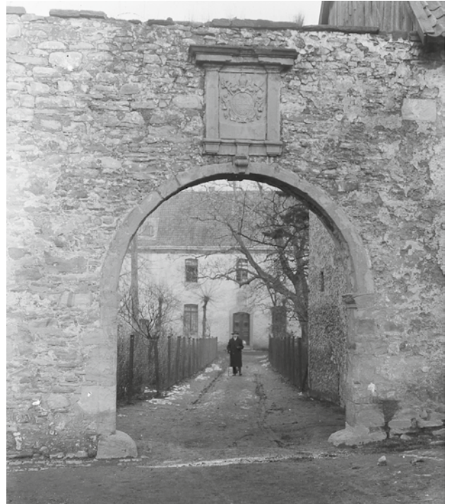
Torbogen an der Westseite (vermutlich um 1920) (Foto: Amt für Geoinformation, Vermessung und Kataster)
