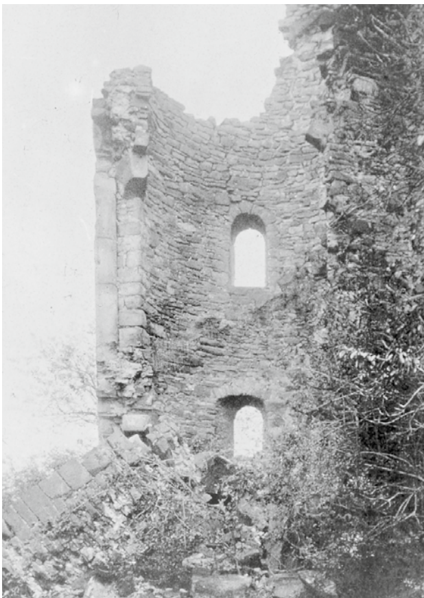
Der zusammengebrochene 7-eckige Trepenturm 1901 (Foto: Albert Ludorff)
