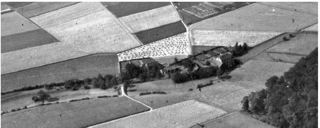
Haus Stein 1926 in einer Schrägaufnahme (Foto: Amt für Geoinformation, Vermessung und Kataster)
