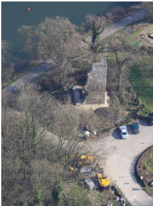
Schrägluftbild des Kattenturm mit Blick Richtung Ruhr (Foto: Baoquan Song, 03.04.2009)
