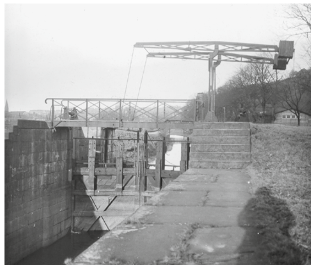
Schleusenoberhaupt mit Klappbrücke der Papiermühlenschleuse in Werden mit Blick Richtung St. Ludgerus. Der nördlich verlaufende Leinpfad (Bildmitte) wird durch die Brücke verdeckt. (Foto: Amt für Geoinformation Vermessung und Kataster, um 1950)
