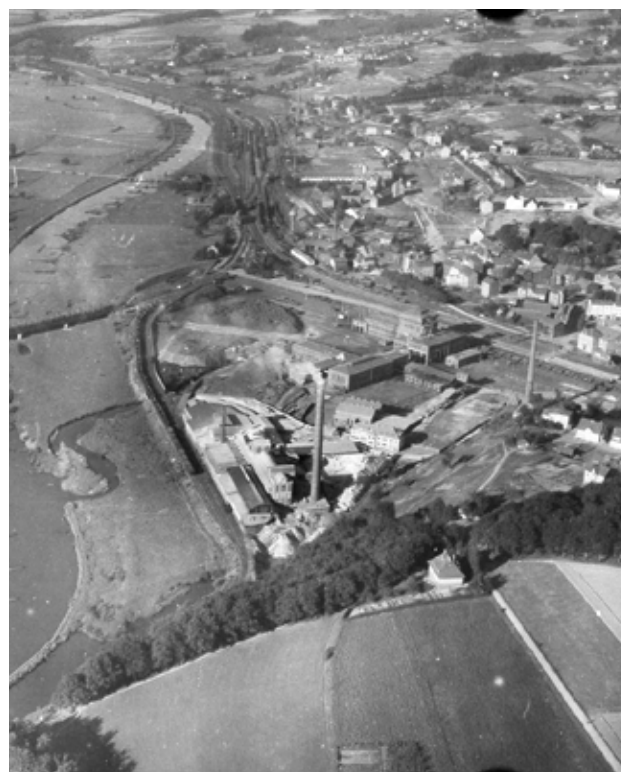
Das Schrägluftbild von 1926 zeigt unter anderem die an der Ruhr gelegene Phoenix-Hütte von Süden her mit Kupferdreh im Hintergrund und der Dilldorfer Höhe am unteren Bildrand (Foto: Amt für Geoinformation, Vermessung und Kataster)
