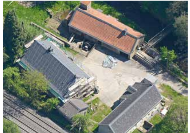
Zu erkennen sind Arbeiten an den so genannten Arbeiterhäusern des Deilbachhammers und das Dach des Hammergebäudes ist neu eingedeckt. Am 17.10.2021 erfolgte durch das Konsortium Deilbachtal die Schlüsselübergabe der Arbeiterhäuser am Deilbachhammer (Foto: Baoquan Song, 03.05.2022)
