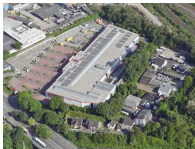
An der Frillendorfer Straße steht heute unter anderem ein großer Baumarkt (Foto: Baoquan Song, 15.05.2022)
