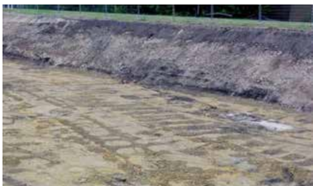
Im lehmigen Untergrund waren 2013 Abdrücke der alten Bahngleise gut zu erkennen (Foto: Detlef Hopp)
