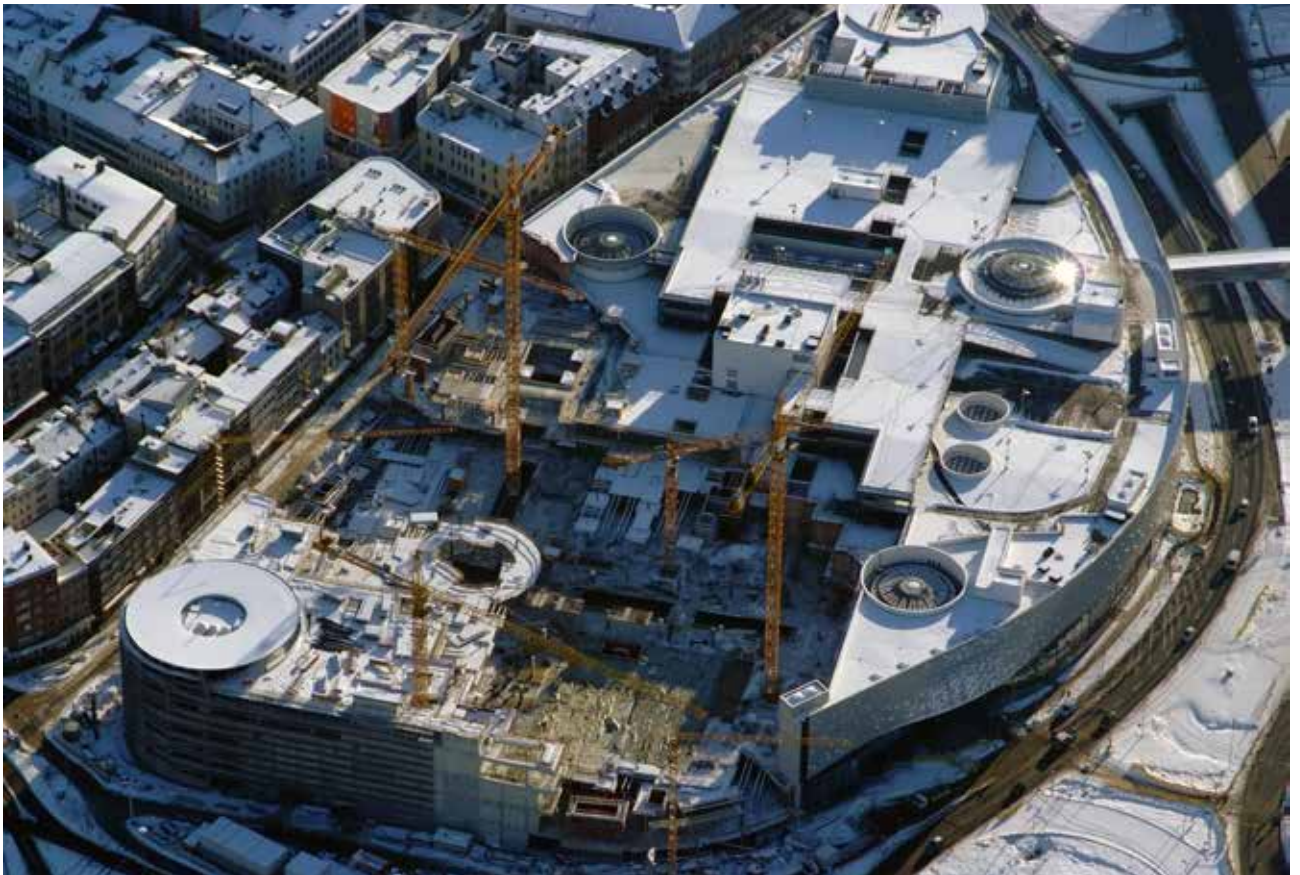
Blick auf den noch nicht fertiggestellten Bau im Winter 2009 (Foto: Baoquan Song, 06.01.2009)
