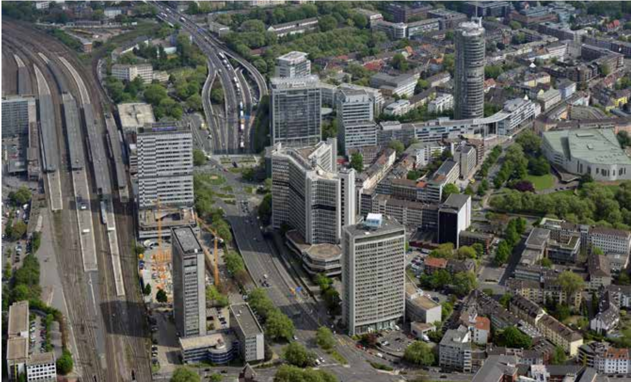
Blick auf den Hauptbahnhof und die südlich davon, zum Teil unterirdisch geführte, A 40 (Foto: Baoquan Song, 24.04.2014)
