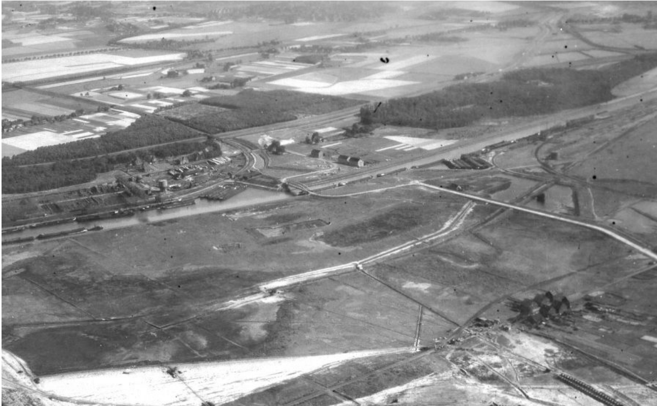
Die von Südwesten her aufgenommene Schrägluftaufnahme von 1926 zeigt das Gelände auf dem kurz darauf die Bauarbeiten für den Binnenhafen begannen. (Foto: Amt für Geoinformation, Vermessung und Kataster)
