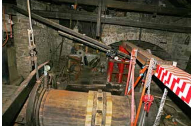
2021 und 2022 fanden Sanierungsarbeiten im Hammergebäude statt (Foto: Detlef Hopp)
