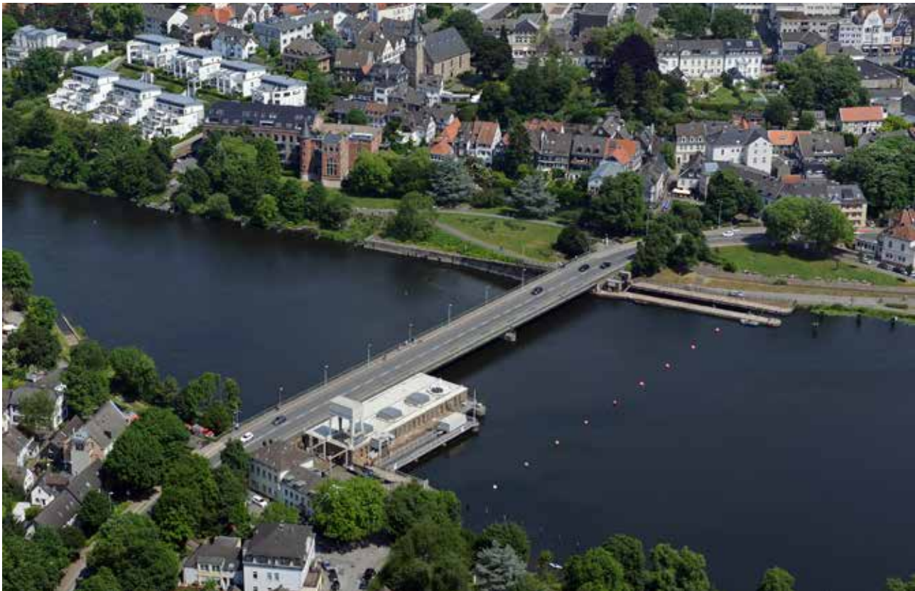
Blick über die Staumauer des Kettwiger Sees auf den historischen Ortskern von Kettwig, die alte Schleuse ist verschwunden (Foto: Baoquan Song, 04.07.2017)
