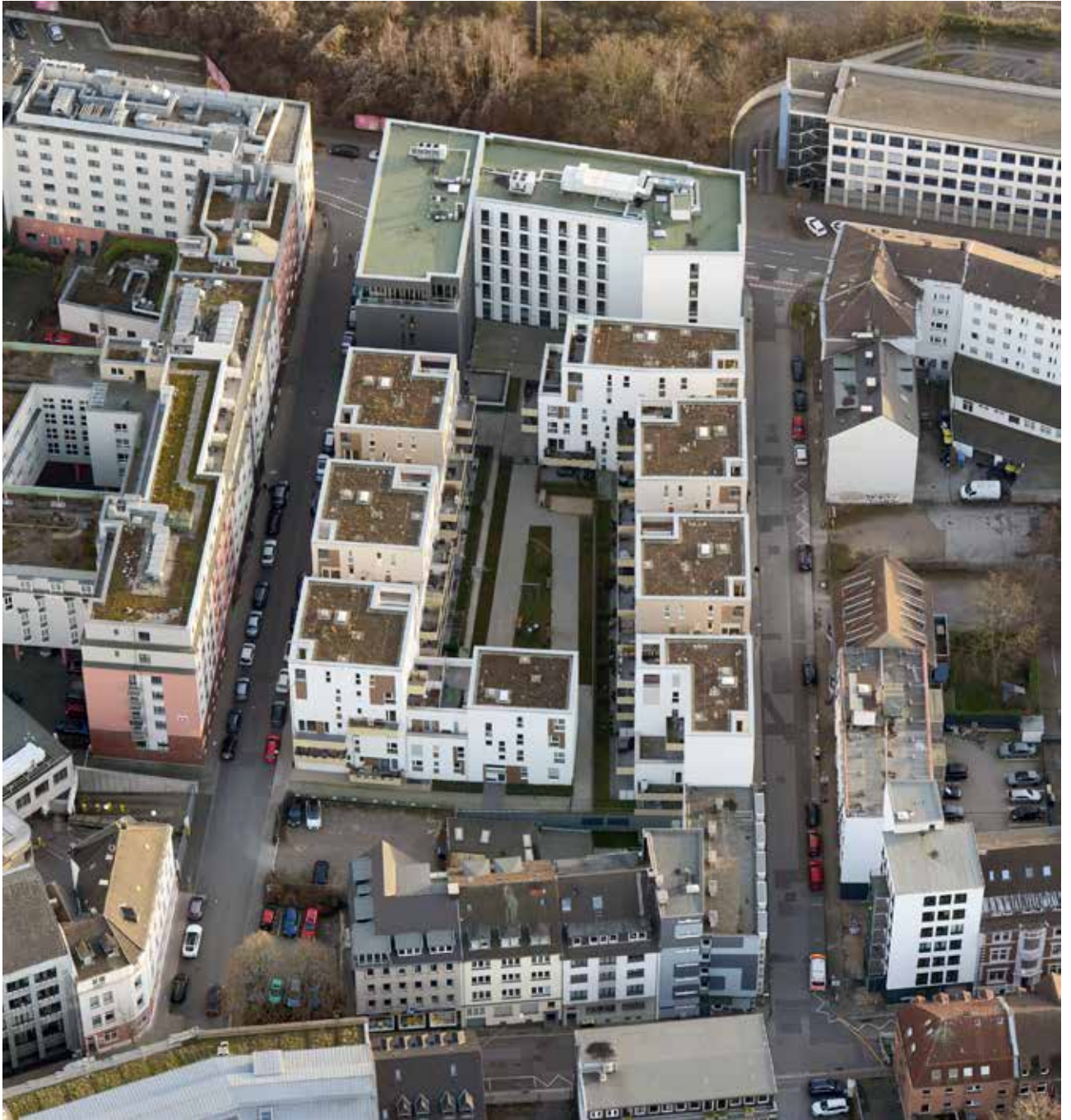
Das Luftbild vom 30.01.2022 zeigt das neu bebaute Areal von Norden: Oben im Bild begrenzt die Hachestraße, links die Selmastraße die Fläche (Foto: Baoquan Song)
