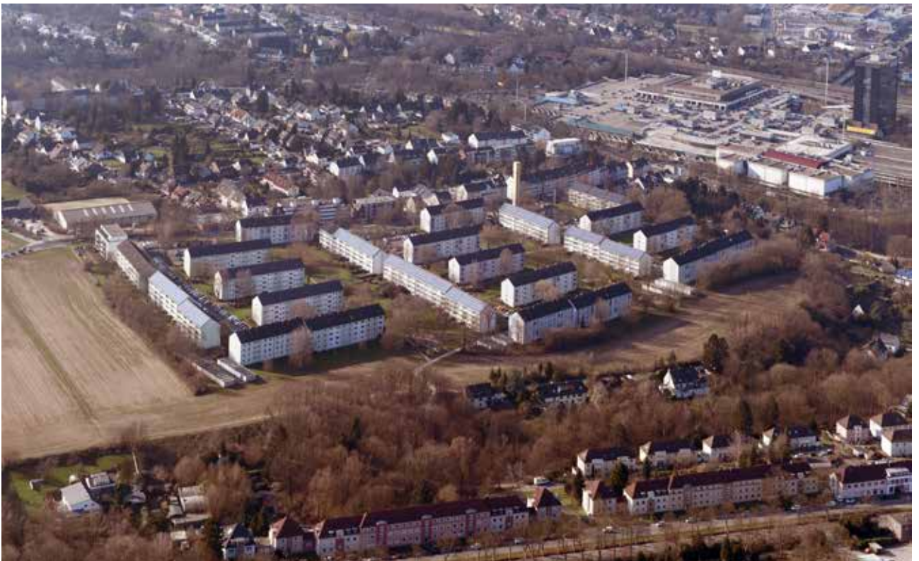
Die Wohnbauten der Siedlung von Südosten aus gesehen (Foto: Baoquan Song, 05.03.2022)
