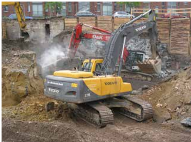
Beim Abriss der Fundamente im Jahr 2006 im Bereich des Siemens-Martin-Werkes VI (Foto: D. Hopp)
