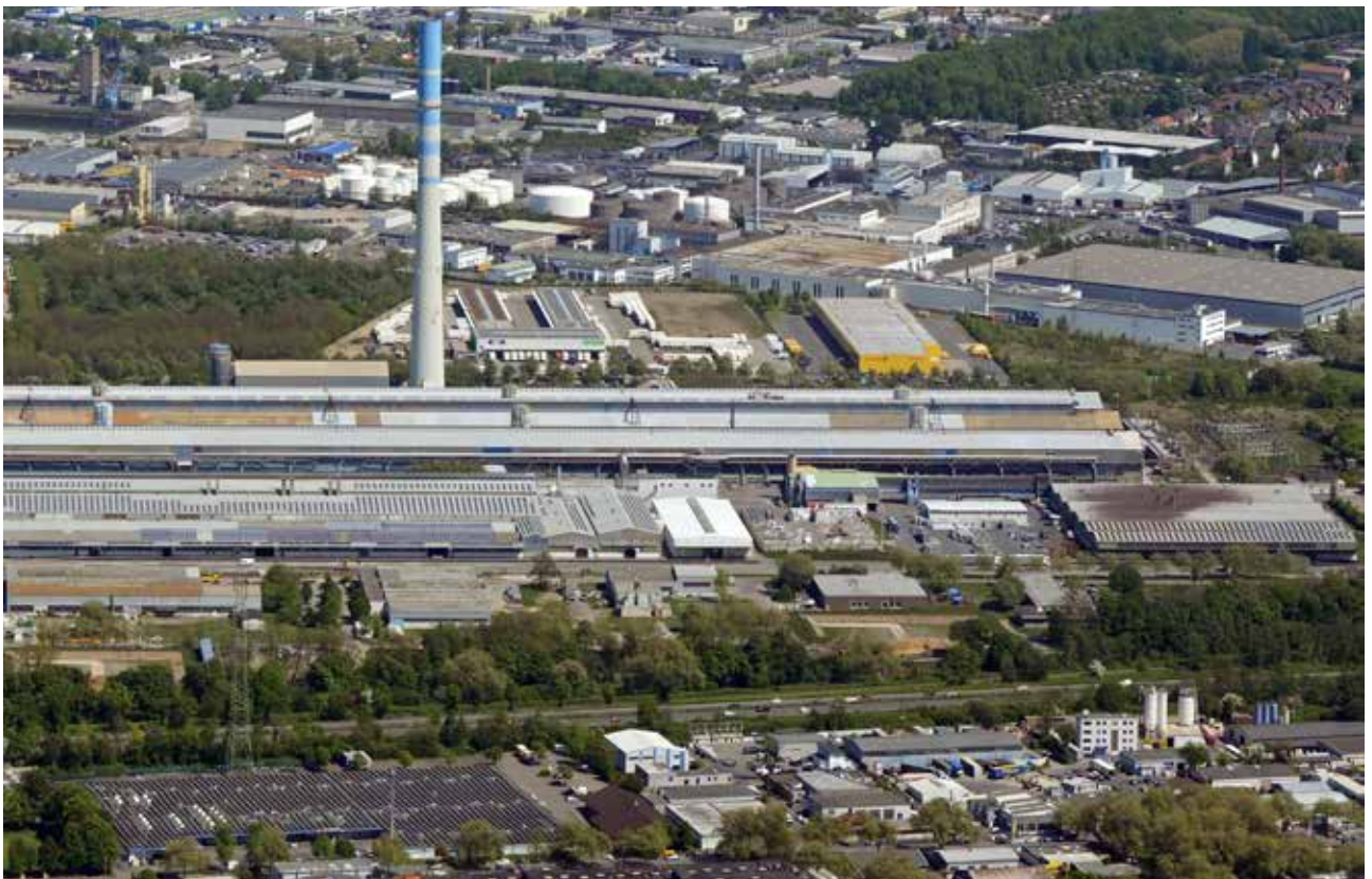
Detailansicht der Hütte, das weiße Dach in der Bildmitte kennzeichnet etwa den Standort vom Haus Heck (Foto: Baoquan Song, 03.05.2022)
