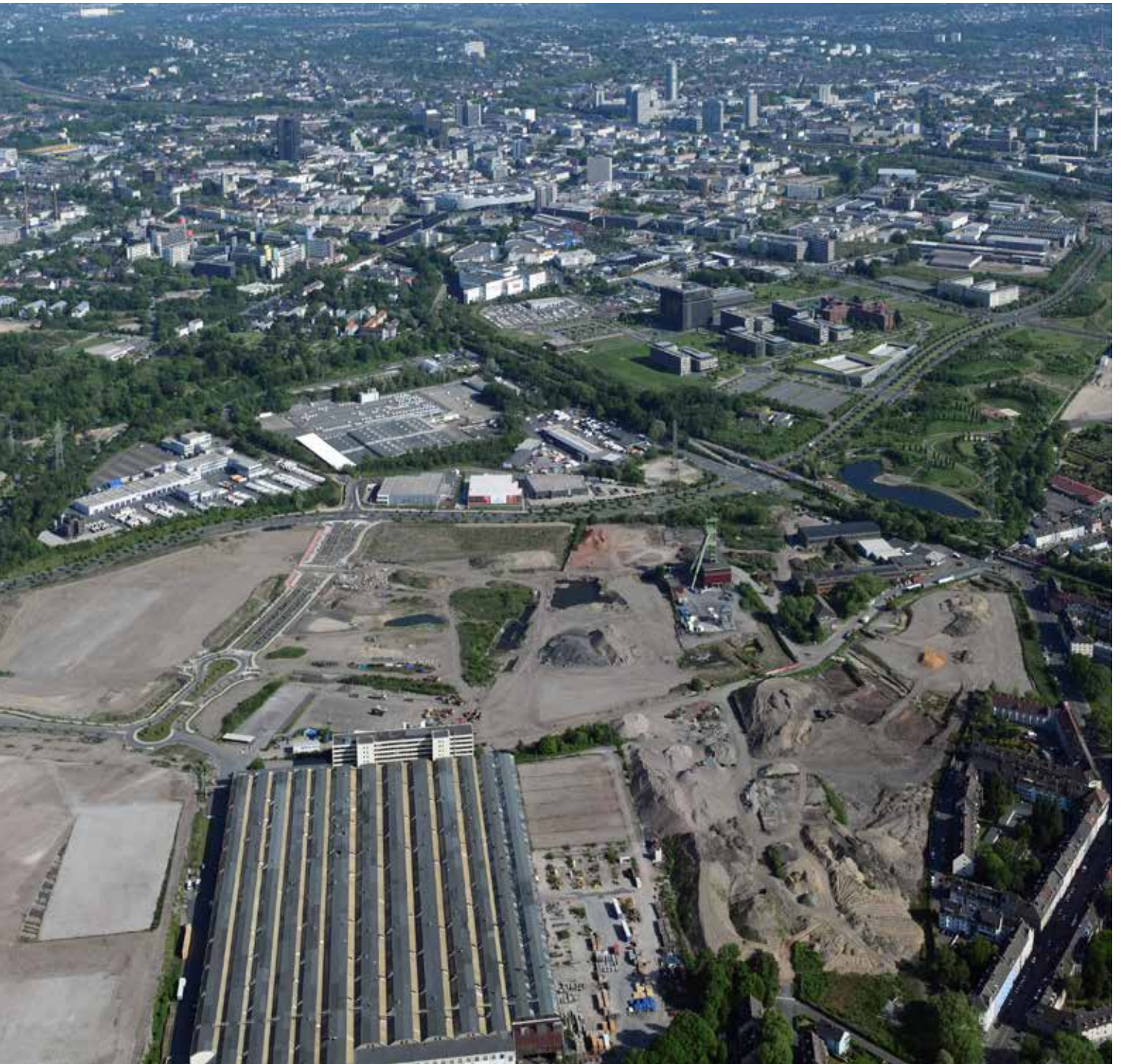
Das am 15.05.2022 aufgenommene Luftbild zeigt das entstehende Areal von "Essen 51", das ThyssenKrupp-Quartier, den Krupp-Park und im Hintergrund die Silhouette der City (Foto: Baoquan Song)
