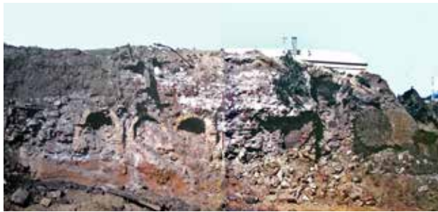
Fundamentmauern im Bereich des Gebläsemaschinenhauses, die bei den archäologischen Untersuchungen im Jahr 2003 entdeckt wurden (Fotomontage: D. Hopp)
