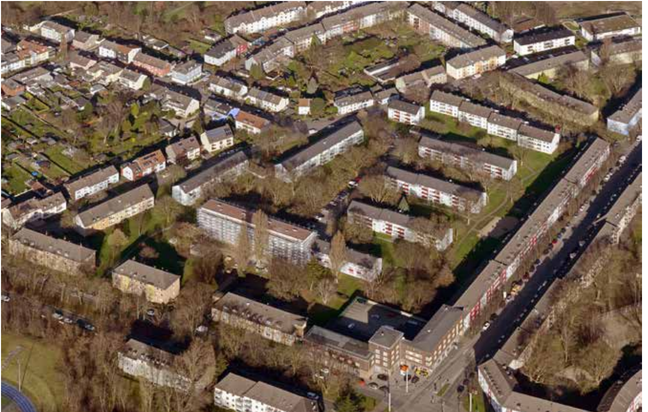
Schon in den 1960er Jahren war das Gelände der alten Ziegelei vollständig bebaut worden. Das Luftbild zeigt den Zustand vom 12.02.2022 (Foto: Baoquan Song)
